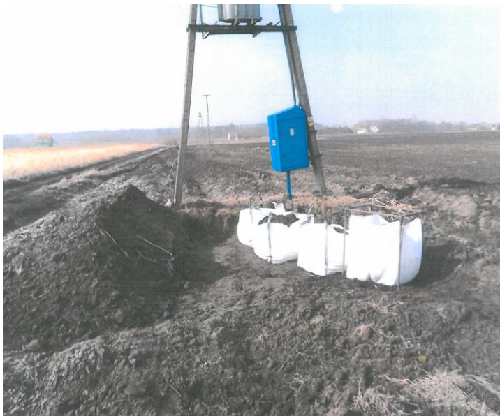
Wymiana ( przez specjalistyczną uprawnioną firmę ) skażonego gruntu pod stacją transformatorową po wylaniu oleju z transformatora w czasie kradzieży uzwojeń.
