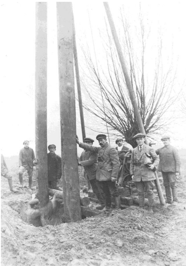
Budowa linii 60 kV Gródek-Toruń
