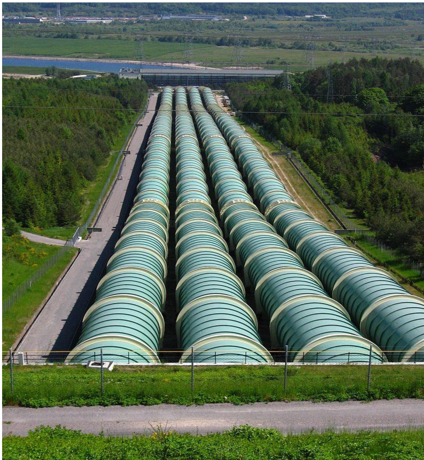
Żarnowiec– rury, które łączą zbiorniki: górny i dolny
